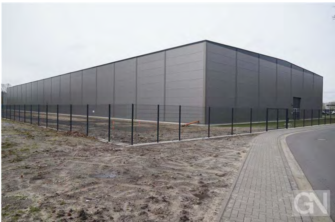
Die neue Logistikhalle ist 7000 Quadratmeter groß. Foto: Schönrock
