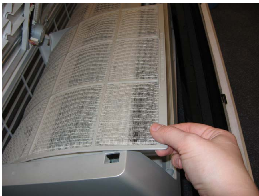
Bild 4: Filterwechsel: Filter werden aus den Einschubleisten herausgezogen
