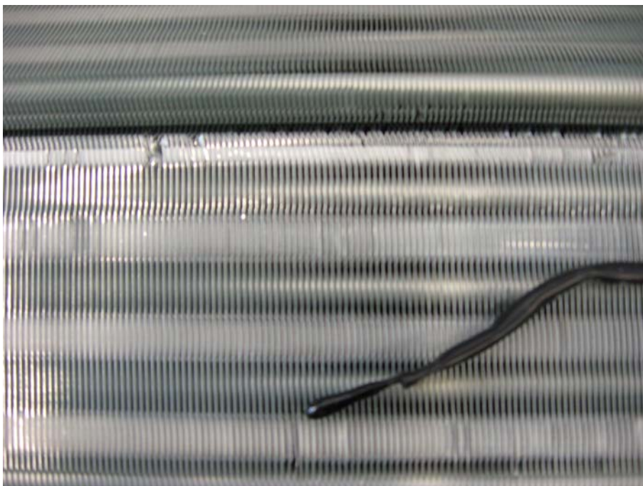
Bild 6: Feuchtefühler der Nachlaufregelung des Ventilators
