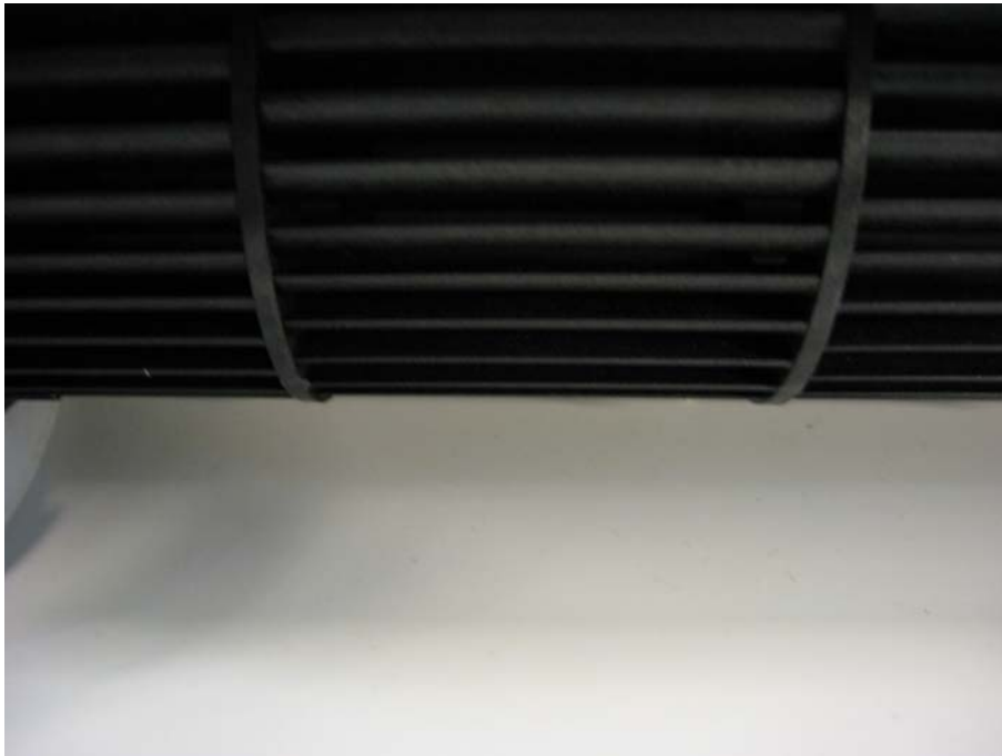
Bild 5: Ventilator des Klimagerätes
