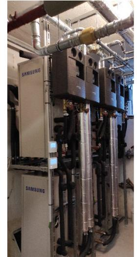
**Die installierte Kühlleistung in diesem Objekt beträgt 117 kW - und die Heizleistung 132 kW**
